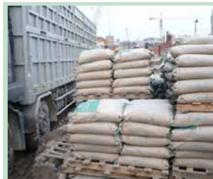
Vữa SCL-MORTAR cấp đến công trình
