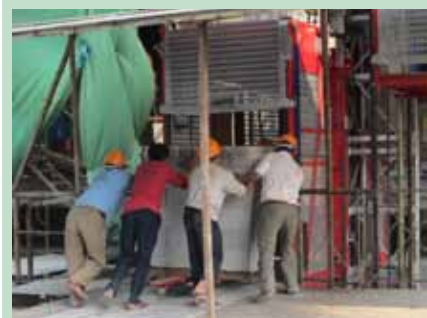
Chuyển gạch lên tầng xây bằng vận thăng
