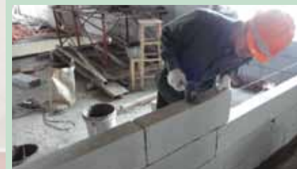
Căn chỉnh gạch bằng búa cao su
