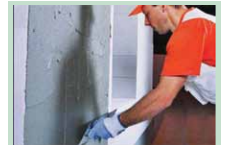
Trát lót trước khi dán lưới sợi thủy tinh
