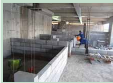
Xây thân tường bằng vữa xây SCL-MORTAR
