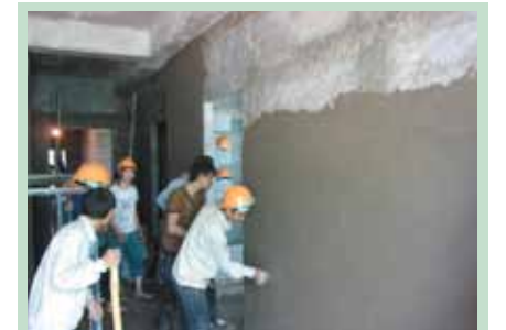
Trát tường hoàn thiện
