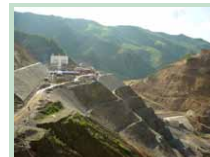
Thủy điện Bản Chát
