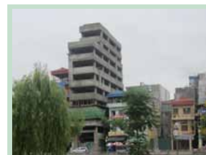
Giai đoạn trát tường hoàn thiện
