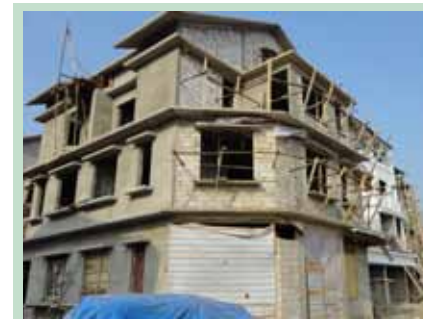
Xây tường nhà biệt thự, khách sạn, bệnh viện
