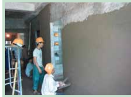
Trát tường bằng vữa trát SCL-MORTAR
