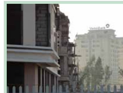
Xây tường nhà cao tầng
