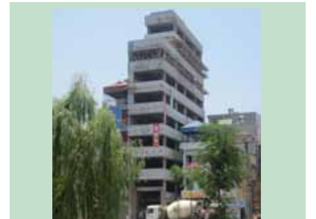
Xây tường nhà dân dụng
