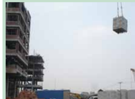
Chuyển gạch lên tầng xây bằng cầu tháp
