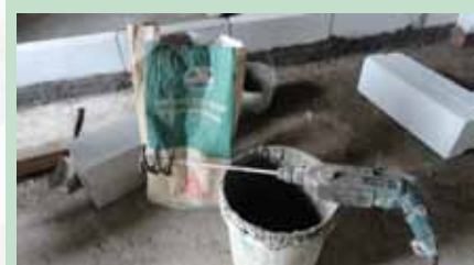
Dùng cánh khuấy lắp vào máy khoan cầm tay để trộn vữa
