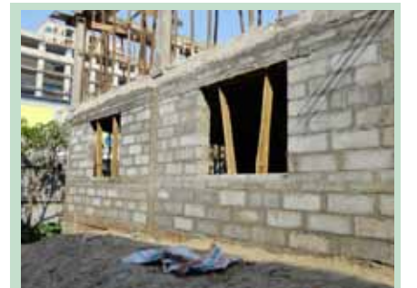
Xây tường nhà xưởng, kho tàng...
