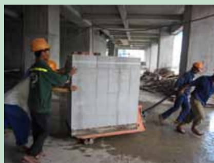
Kéo chuyển gạch trên sàn thi công
