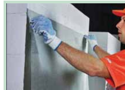
Dán lưới sợi thủy tinh trước khi trát phủ
